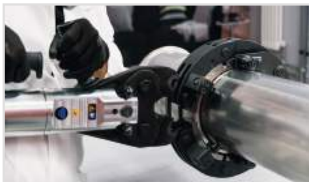
Assemblaggio pressatura n°1 / Press assembly phase 1
